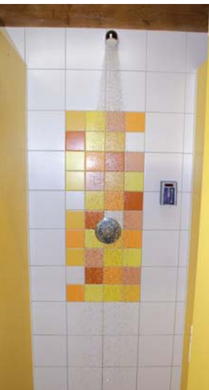
Mit der Transponder-Karte haben es die Campinggäste selbst in der Hand, wie viel sie für das Duschen zahlen, und steuern auf einfachste Weise einen bewussten Umgang mit vorhandenen Energie-Ressourcen.
